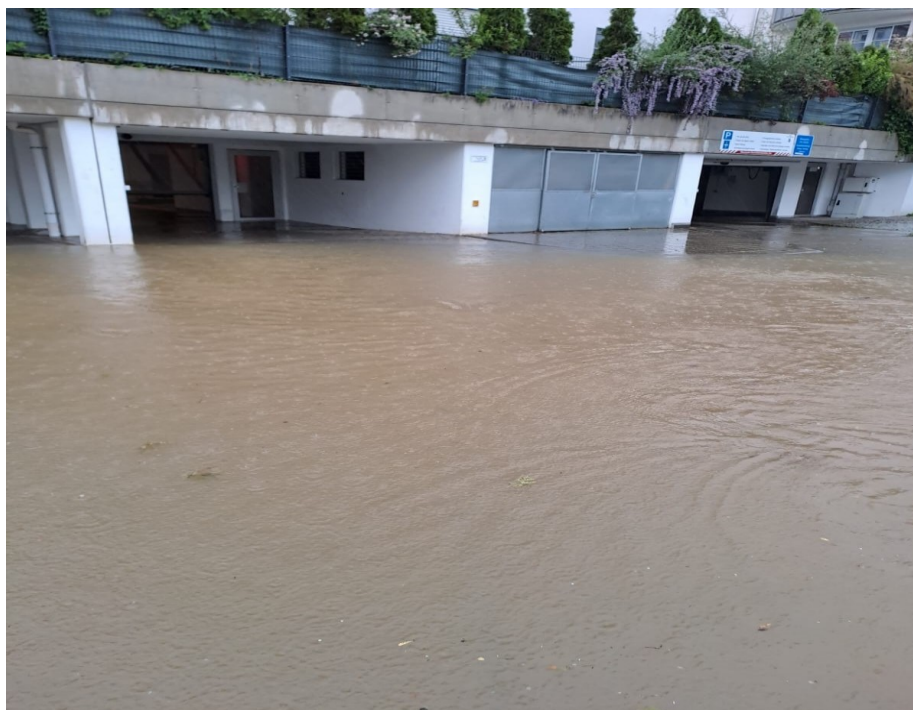
Einfahrt zur Tiefgarage hinter dem Marktplatz
